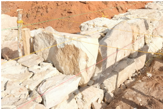
Absatz im Fundament
