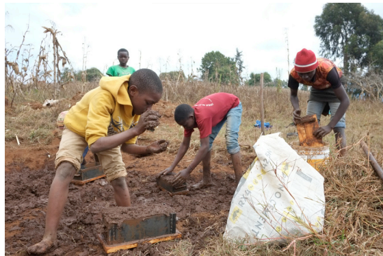
Die fertige Mischung muss in die Schalung gepatzt werden.
