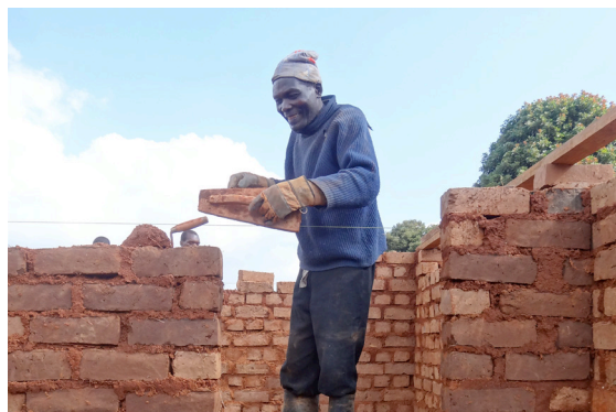
für die Innenwand werden unsere Isele-Adobe verwendet.
