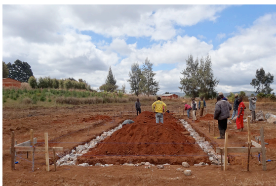
Der Fundamentgraben wird mit Steinen aufgefüllt
