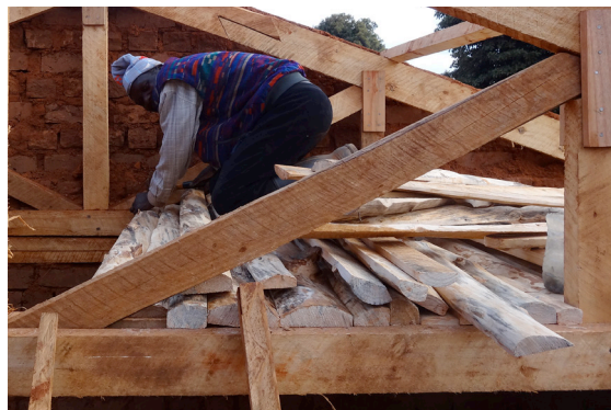
Kassian bei der Montage der Schwartenbretter
