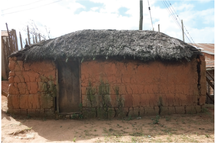
Lehm ist nicht wasserfest: Die schwerwiegenden Folgen von Nässeeinwirkung bei schlechtem bautechnischem Schutz sind diesem Wohnhaus in Mda-bulo, Tansania, deutlich anzusehen.
