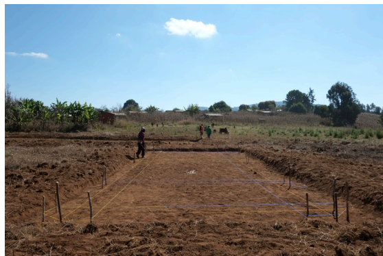
Ökonomiegebäude; Ausgestecktes Schnurgerüst der Foundation
