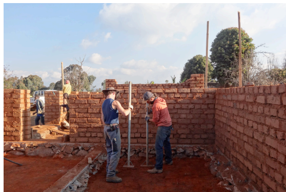
Einbringen & verdichten von Isele Lehm als Bodenauffüllung
