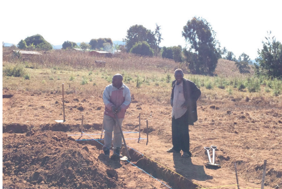
Fidelis vertieft den Fundamentgraben
