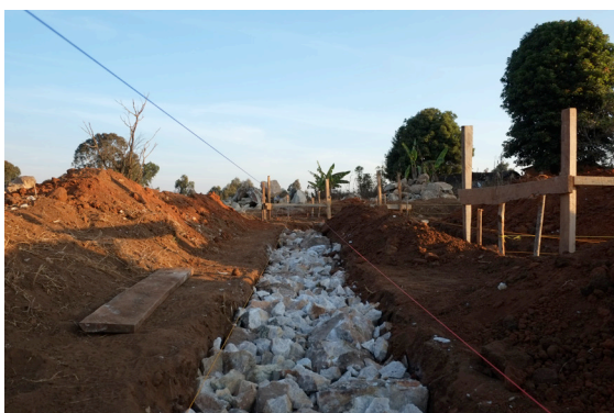
Der breite Fundamentgraben unter den Stützen wurde aufgefüllt
