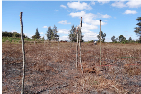
Mit Schnüren werden die Streifenfundamente markiert
