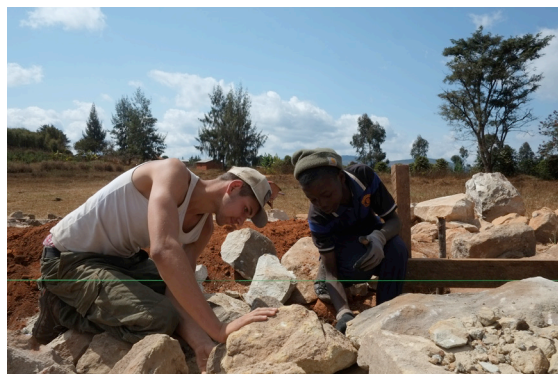
Weiterbau am Fundament des Verwaltungsgebäudes
