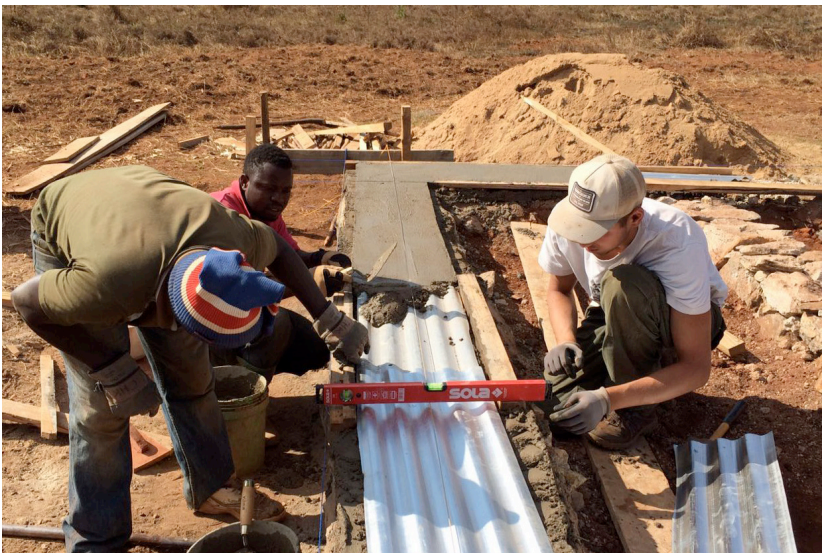
Hauptverursacher des Primärenergiebedarfs: das Wellblech so wie der Zement sind die Hauptverursacher für den Primärenergiebedarf. Hier als Schutz gegen aufsteigende Feuchtigkeit.
