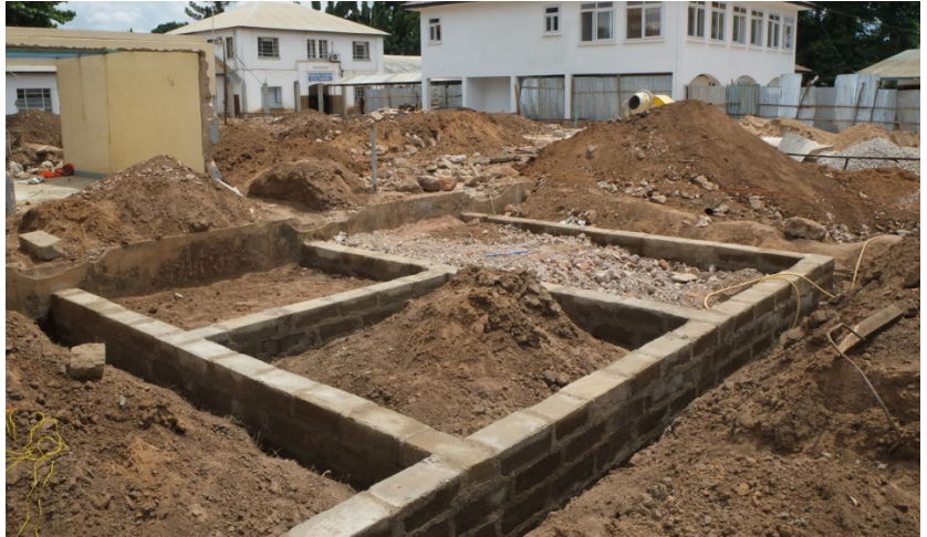
Fundament, Ifakara: gemauertes Zementsteinfundament mit lokal gefertigten Steinen. St. Francis Hospital, Ifakara
