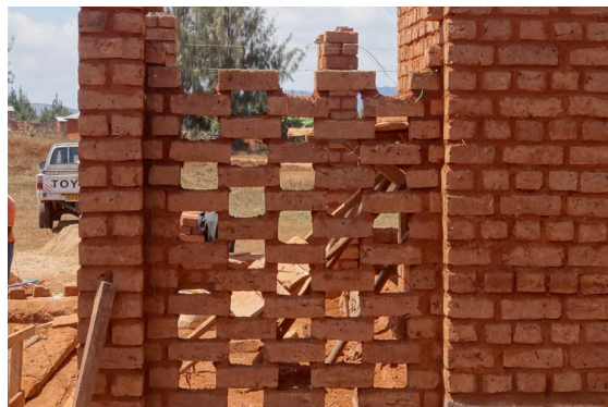
Die perforierte Wand wird weitergebaut.
