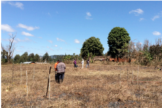
Ausstecken der Fundamente
