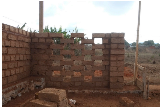
Zwischenstand des Lichtfilters: Er wird präzisiert, wenn er gleichzeitig mit der Wand hoch gezogen wird.
