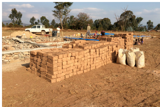
Die Adobeziegel werden neben dem Fundament aufgestapelt
