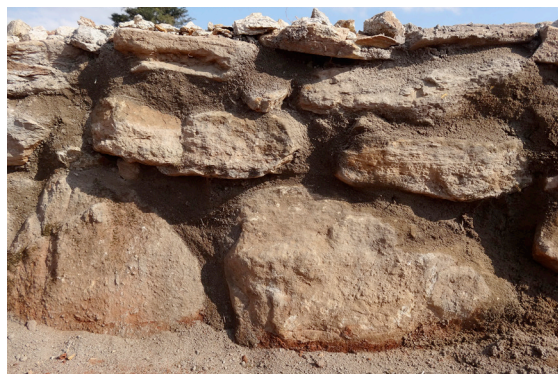
Die Fugen der ehml. Trockensteinmauer werden mit Zement aufgefüllt.
