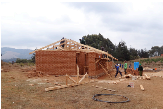
Montage/Ausrichtung Dachbinder und Sparren
