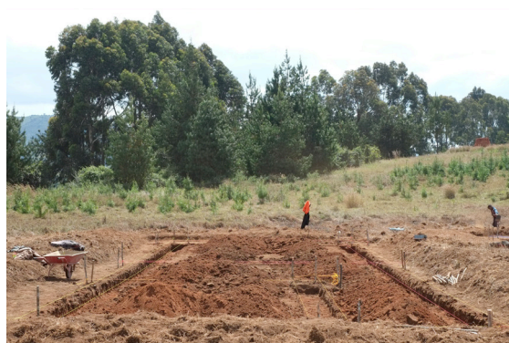
Die Gräben für die Fundamente sind ausgehoben
