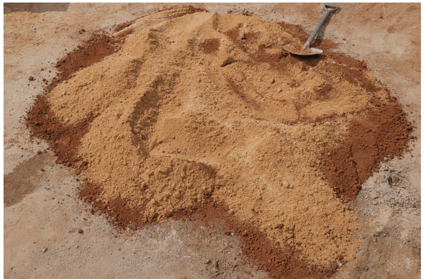
Mörtelpräparation: Auf der Baustelle wird die Mörtelmischung hergestellt; mit der Schubkarre das Verhältnis der Teile abgemessen. Die grosse Menge des benötigten Sands ist aufgrund des Farbunterschieds zum dunklen Lehm augenfällig.
