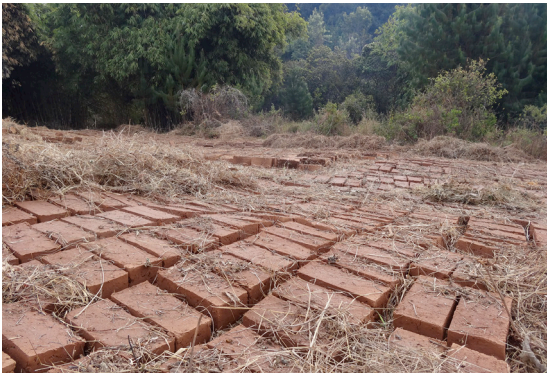
Steine beim Trocknen, leider auf abschüssigem Terrain
