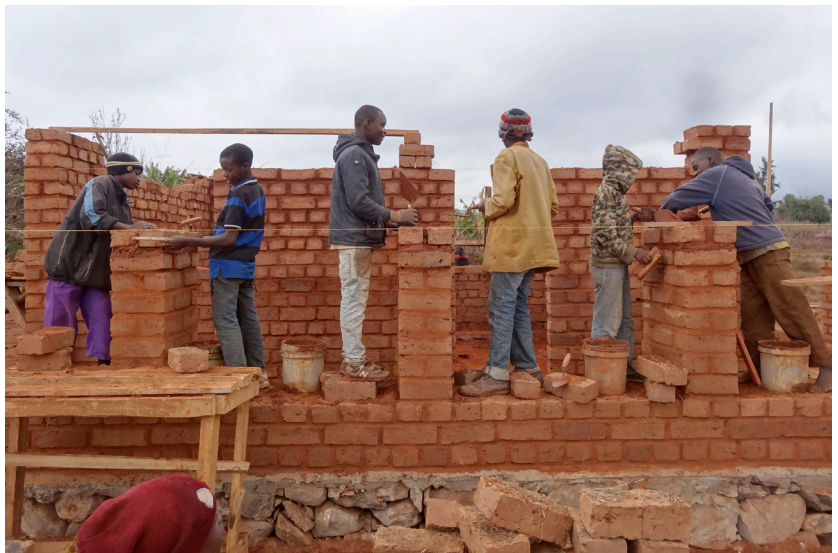
Maurerarbeiten: Die Handwerksschüler mauern die Stützen aus Adobe und Lehmörtel entlang des Zwischenraumes.
