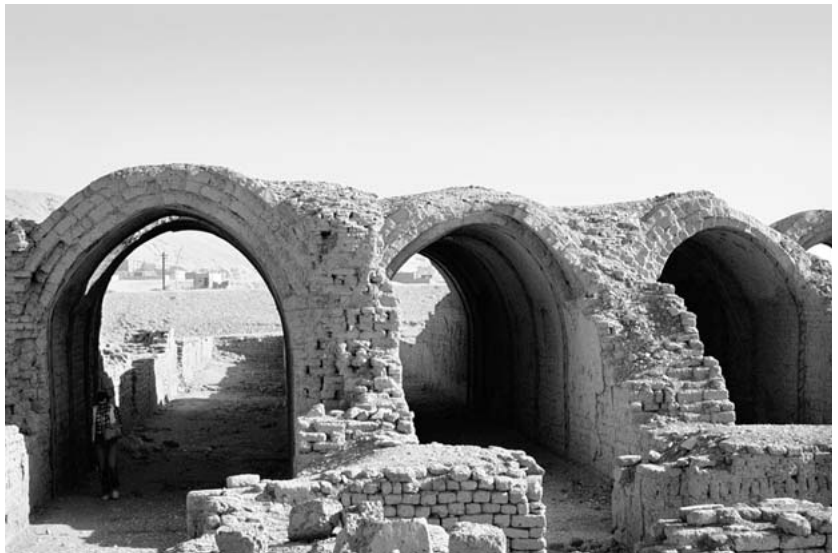
Abb.03 Zeugen der Bautechnik: Die Gewölbe des Totentempel Ramses des Zweiten bei Gourni in Oberägypten wurden ca. 1200 v.Chr. aus ungebrannten Lehmsteinen gebaut.
