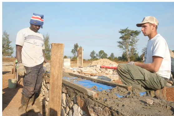
Beim Verwaltungsgebäude wird mit der Ausgleichsschicht begonnen.
