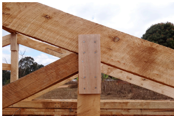
Knotenverbindung Dachbinder
