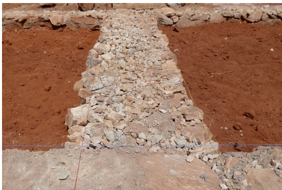
Ergänzung des Fundamentes; Verbreiterung um 28cm nach links
