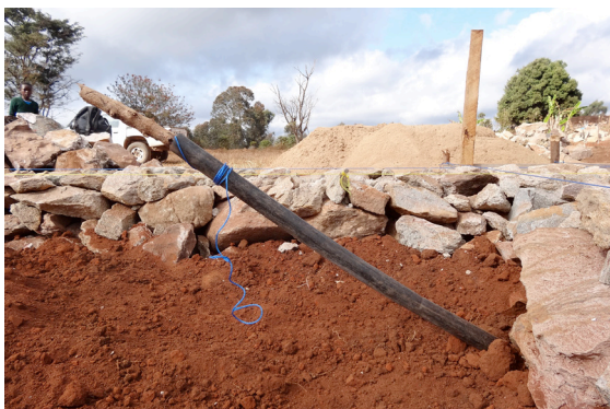
Rohreinlage zur Verbindung des Solarstromes
