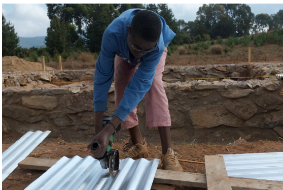
Zuschnitt der Wellblechresten für die Fundamentkronen des Oekonomiegebäudes
