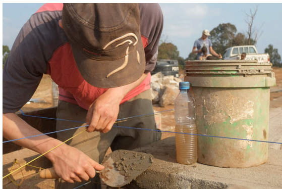
Abschlussarbeiten am Zementbankett
