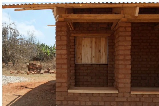
Counteröffnung und Bank konnten befestigt werden
