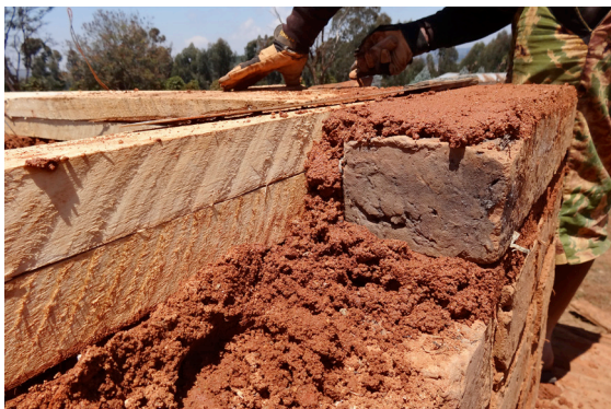
Gebäudeecke; Ringbeam mit Vormauerung
