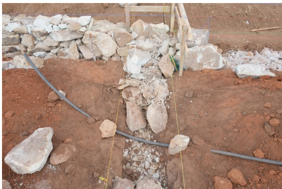
Einlage des Rohres für die Stromverbindung
