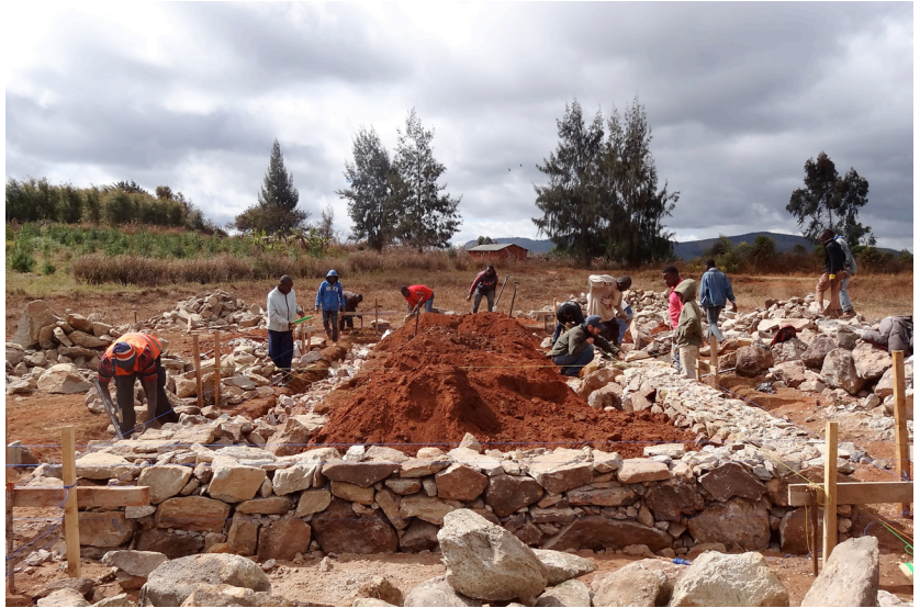
Fundamentarbeiten: Trockenmauer als Fundament des Ökonomiegebäudes
