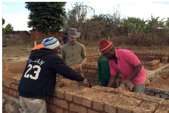
Die Steine werden zuerst alle positioniert. Wenn das Fugebild stimmt, werden die Stossfugen gefüllt.
