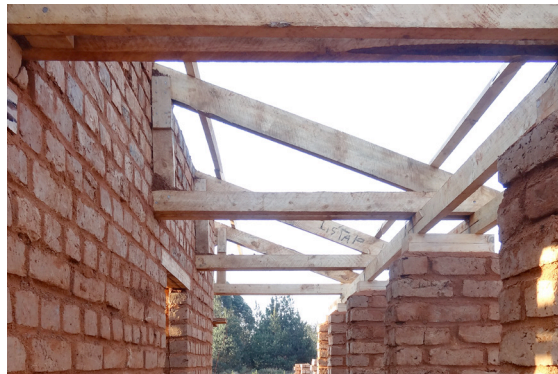
Aufmauerung zwischen Dachbindern
