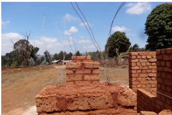
Die Integration der Drähte in den Stützen
