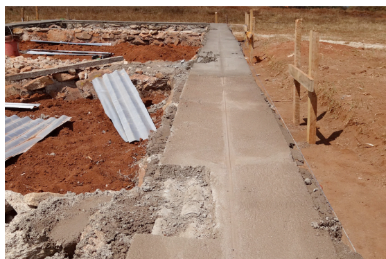
Aussparung Wandanschluss
