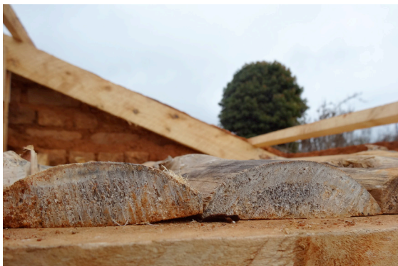
Die Schwarten werden auf die Zange montiert
