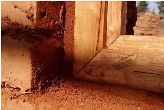
Das Fenster wird mit Lehmörtel abgedichtet
