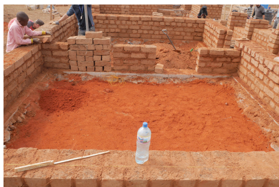
einbringen von Isele Lehm als gestampfte Feuchtigkeitssperre.
