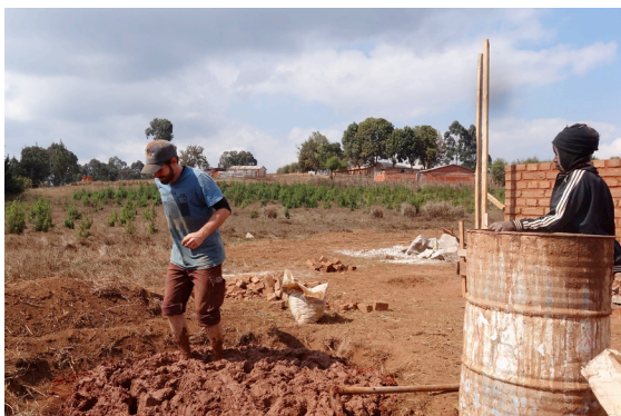
Mischung für die Bodenplatten: 8 Kübel Isele Lehm zu 1 Fass Kikurue eingesumpft.
