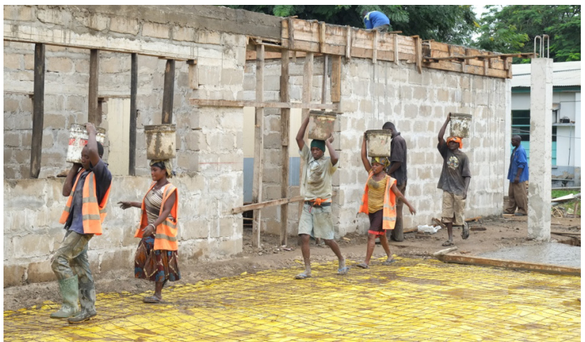
Bodenaufbau und Ringbeam, Ifakara: ArbeiterInnen beim Errichten eines typischen Bodenaufbaus mit PE-Folie und Armierungsgitter. Abschluss der Wand mit betoniertem Ringbeam. St. Francis Hospital, Ifakara
