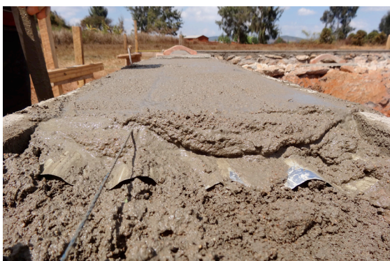
Eingemörteltes Wellblech
