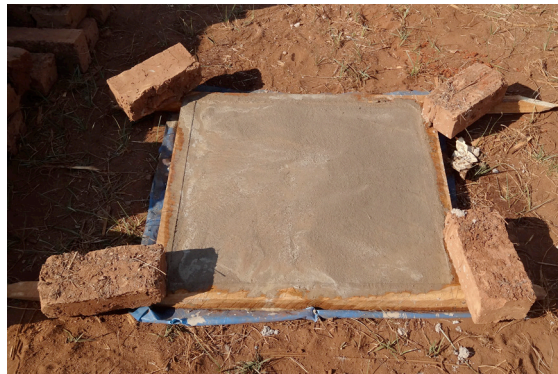
Der Kaminhut wird am Boden vorfabriziert.
