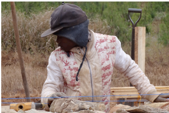
Die obersten Steine werden eingepasst
