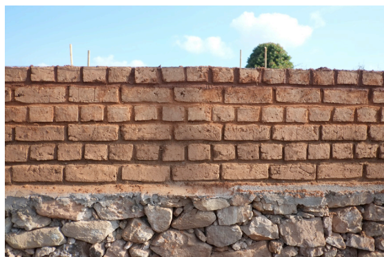
Stand der Arbeit: Die Fugen haben je nach Art des Lehms eine unterschiedliche Färbung.
