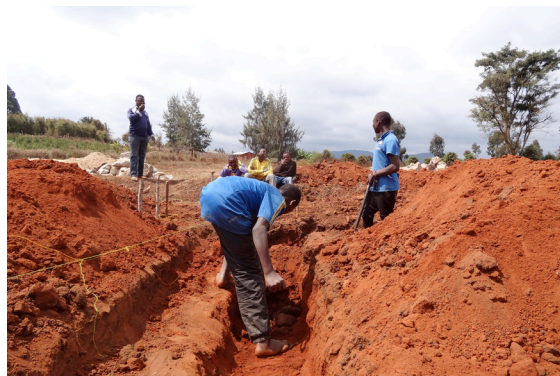
Vertiefung des Aushubes beim Verwaltungsgebäude
