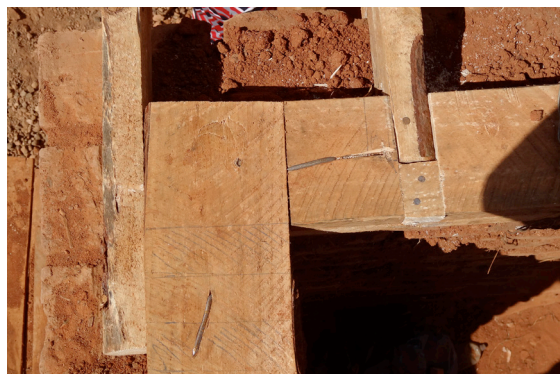
Träger und Ringbeam werden miteinander verbunden.
