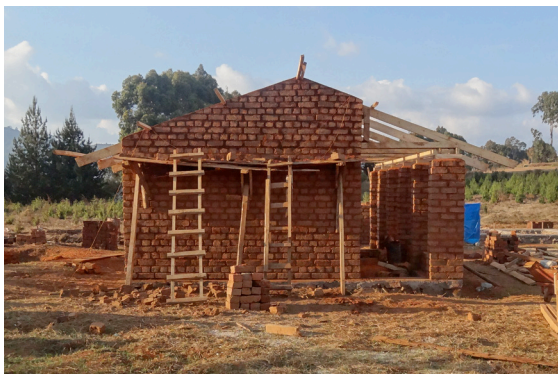
Die fertige Giebelwand mit vorgetäuschem Verband ab dem Dachträger :D.
