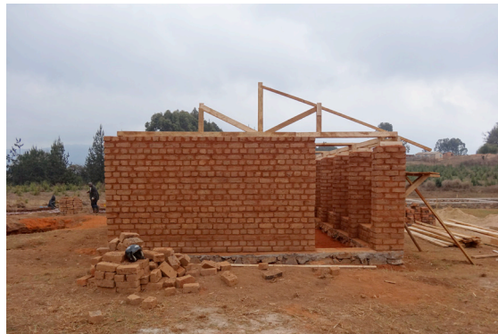
Montage Dachbinder
