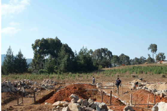
Schnurgerüst und zu ca. 50% gefüllter Fundamentgraben.
