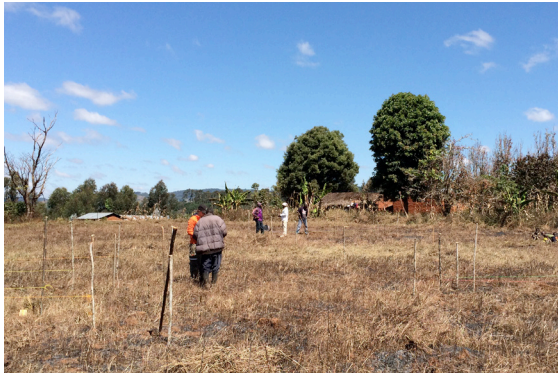
Ausstecken der Fundamente
