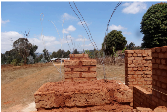
Die Integration der Drähte in den Stützen
