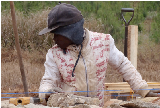
Die obersten Steine werden eingepasst
