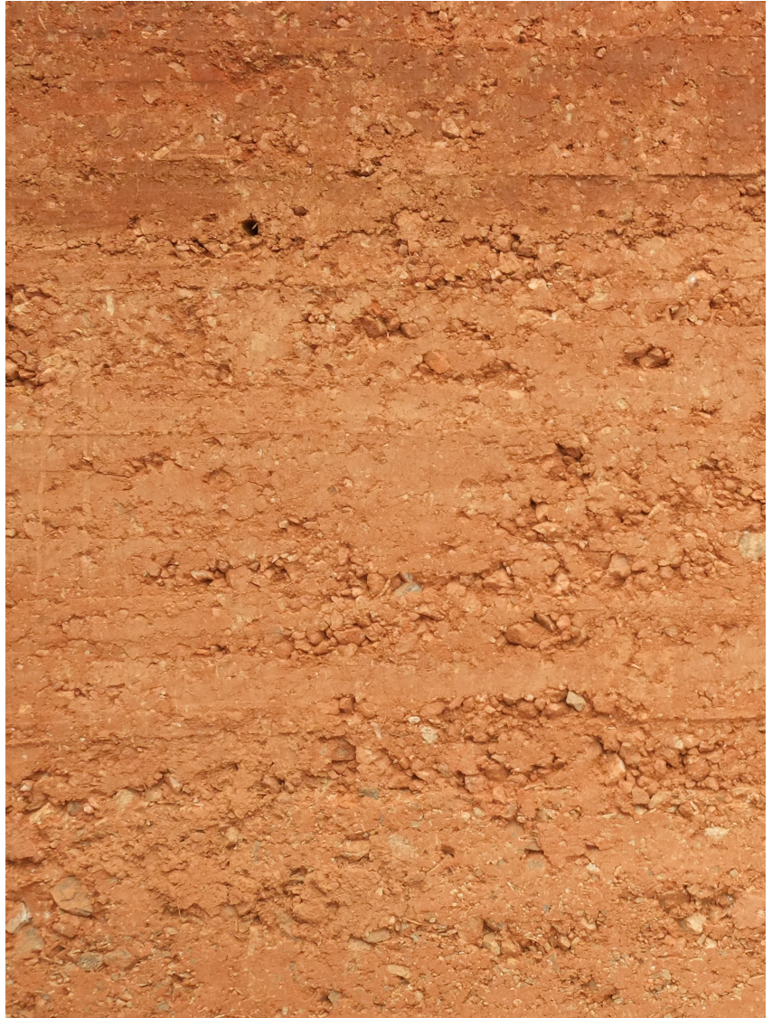
Oberfläche einer steinigen Stampflehmvand, Mdabulo
