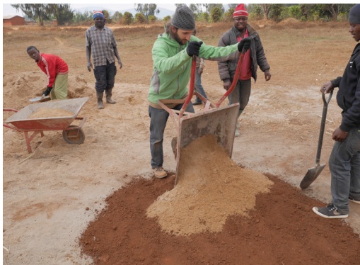
Mit der Schubkarre wird das Mischverhältnis Lehm/Sand abgemessen
