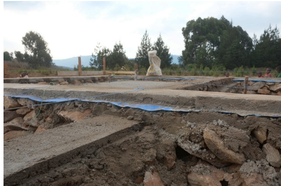
Das Auflager der Balken im Meetingraum (v.l.) und das Fundament des Safes (mitte)
