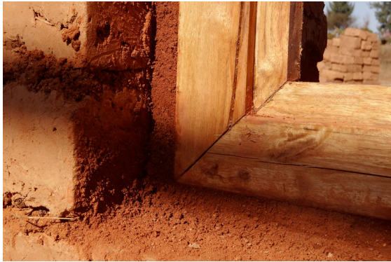
Das Fenster wird mit Lehmörtel abgedichtet
