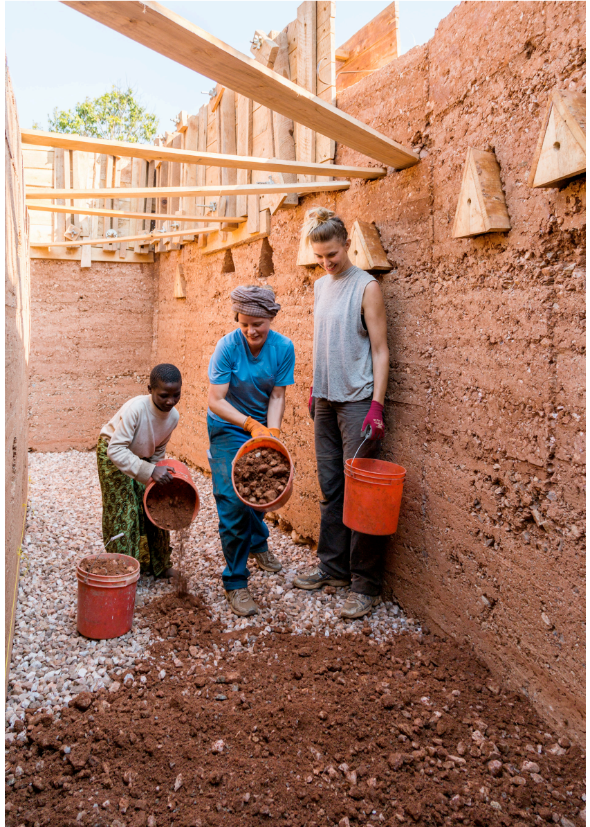
Abb.46 Einbringen der ersten Lehm und Steinmischung auf die Kieskofferung.
