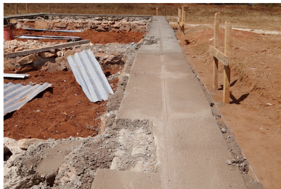
Aussparung Wandanschluss
