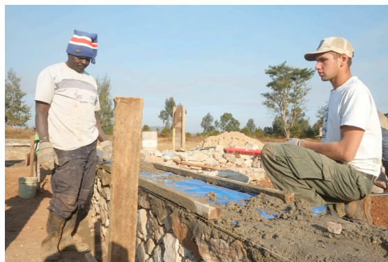
Beim Verwaltungsgebäude wird mit der Ausgleichsschicht begonnen.
