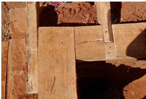
Träger und Ringbeam werden miteinander verbunden.
