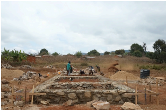
Die Fugen sind ausgemörtelt, es fehlt noch die Ausgleichsschicht
