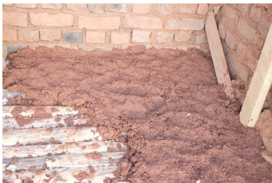
Die Decke des Kioskes wird mit einer Lehm/Hobelspäne-Mischung bedeckt.
