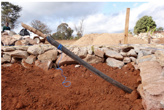
Rohreinlage zur Verbindung des Solarstromes
