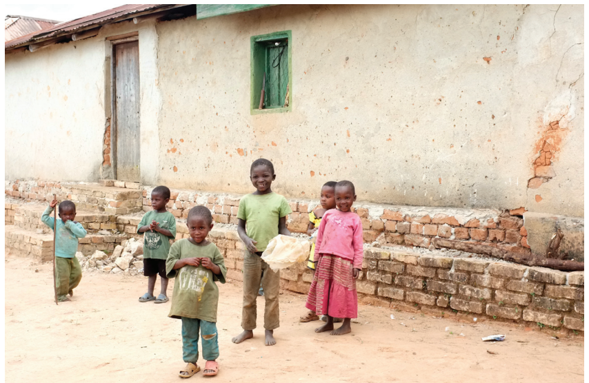
Abb.40 Gebrannte Lehmsteine als Fundament; Die Stufen können als Sitzbank genutzt werden. Jedoch bergen sie die Gefahr von stehendem Wasser bei Regen. Man erkennt, dass die dunkel verfärbten Steine der Bewitterung ausgesetzt sind.
