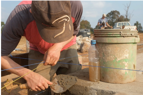
Abschlussarbeiten am Zementbankett
