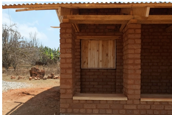
Counteröffnung und Bank konnten befestigt werden
