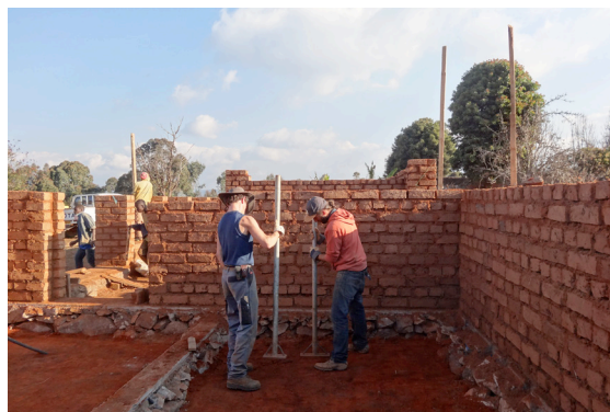
Einbringen & verdichten von Isele Lehm als Bodenauffüllung
