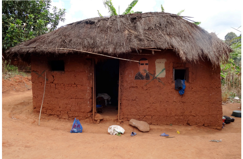
Abb.61 Haus in Isele mit beschädigtem traditionellem Grasdach
