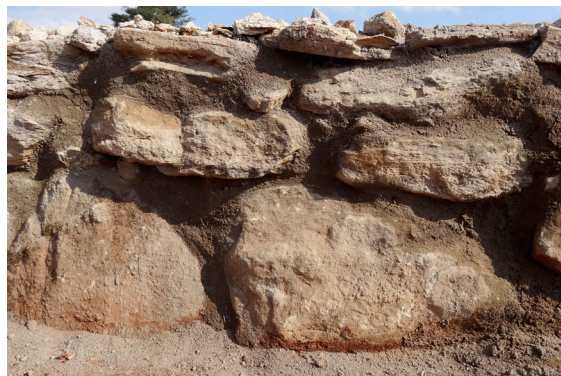
Die Fugen der eh. Trockensteinmauer werden mit Zement aufgefüllt.
