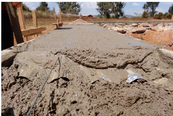
Eingemörteltes Wellblech
