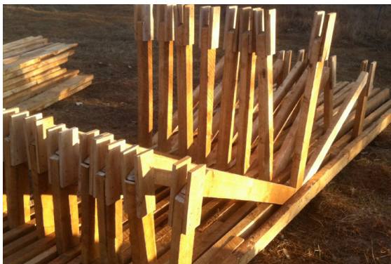
Die vorbereiteten Dachbinder
