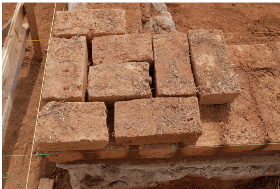
Das Detail der Ecke mit Stütze und Bank wird trocken ausgelegt.
