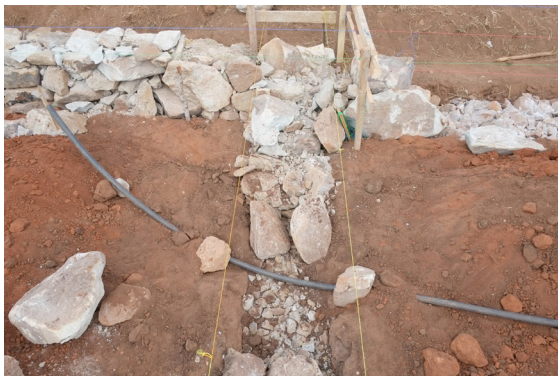
Einlage des Rohres für die Stromverbindung
