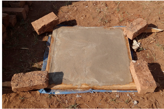
Der Kaminhut wird am Boden vorfabriziert.
