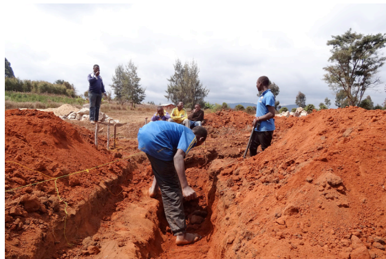
Vertiefung des Aushubes beim Verwaltungsgebäude
