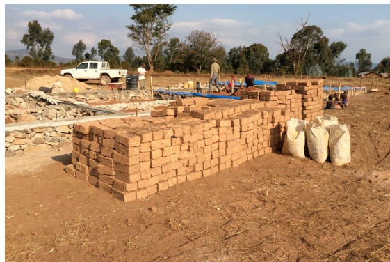
Die Adobeziegel werden neben dem Fundament aufgestapelt
