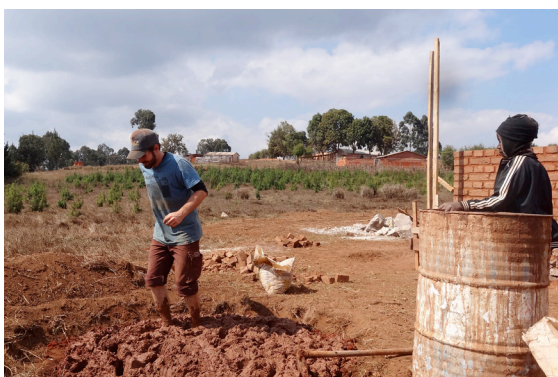
Mischung für die Bodenplatten: 8 Kübel Isele Lehm zu 1 Fass Kikurue eingespumpt.
