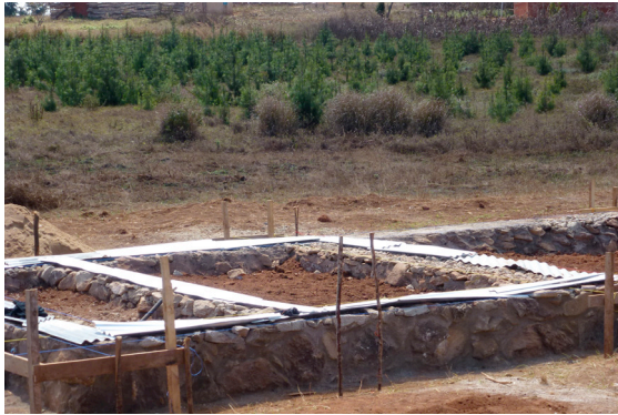
Die zugeschnittenen Wellblechteile auf dem Fundament des Oekonomiegebäudes
