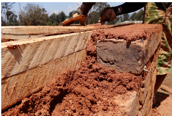
Gebäudeecke; Ringbeam mit Vormauerung
