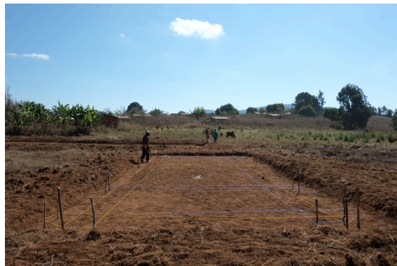
Ökonomiegebäude; Ausgestecktes Schnurgerüst der Foundation
