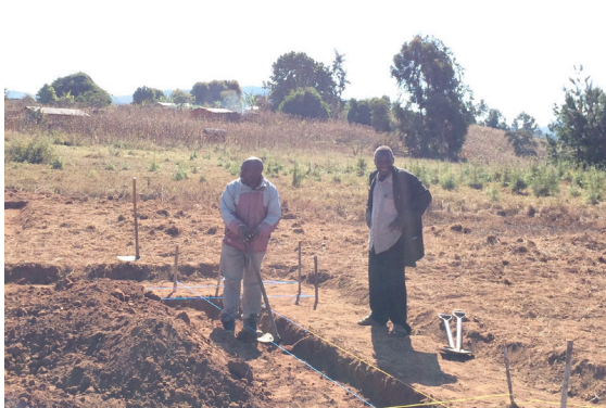
Fidelis vertieft den Fundamentgraben
