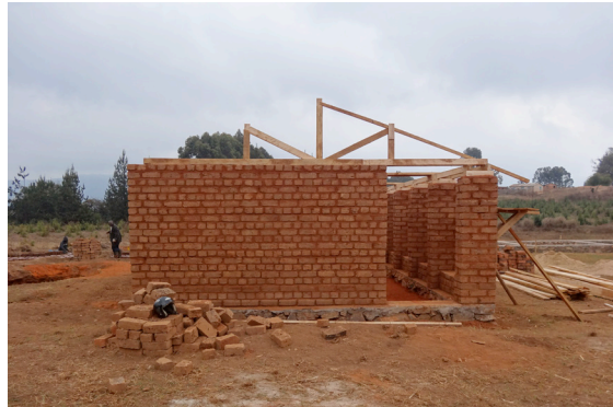
Montage Dachbinder
