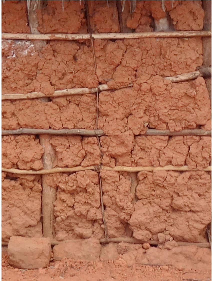
Abb.47 Oberfläche eines Flechtwerkes mit Lehmbewurf um Isele
