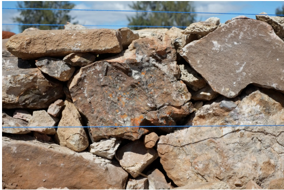
Abschnitt der Trockenmauer, links der Mitte ein von aussen gesetzter Keil
