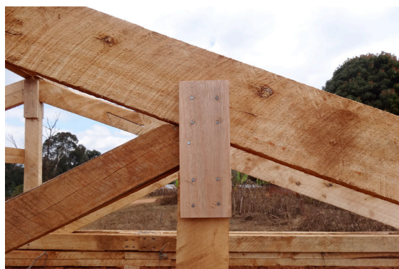
Knotenverbindung Dachbinder
