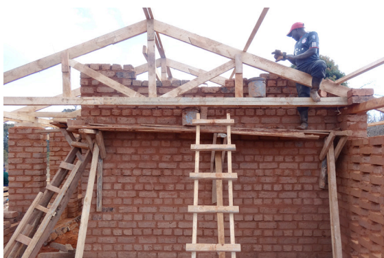
Mauern der Giebelwand
