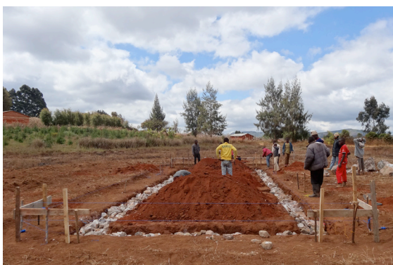
Der Fundamentgraben wird mit Steinen aufgefüllt
