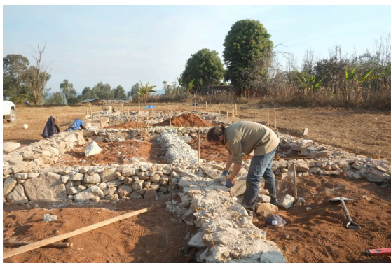
Für die Balken der Holzböden werden weitere Auflager gemauert
