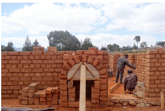
Gemauerter Rundbogen Ofen
