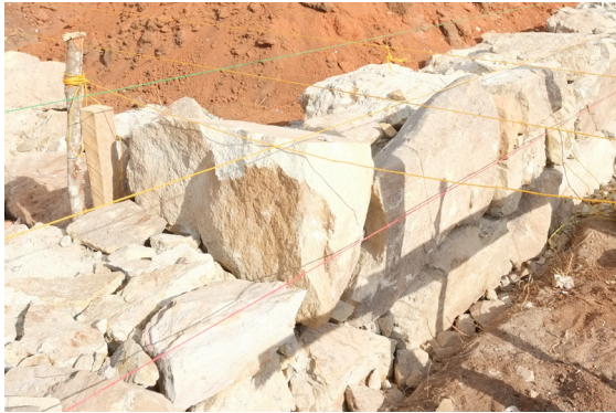
Absatz im Fundament
