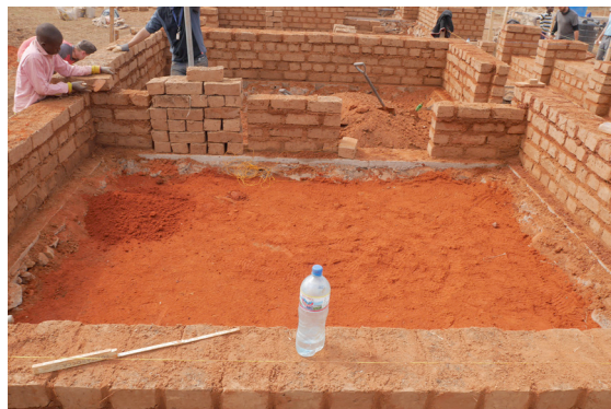
einbringen von Isele Lehm als gestampfte Feuchtigkeitssperre.
