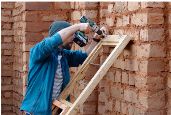
Montage von Metallwinkel für die Befestigung am Sturzbalken
