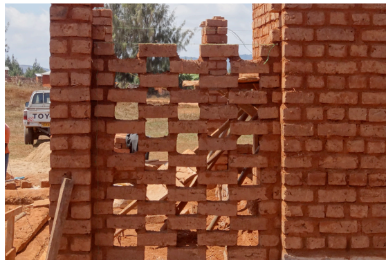
Die perforierte Wand wird weitergebaut.
