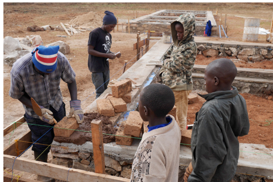
In der NW-Ecke wird der erste Ziegel gesetzt.
