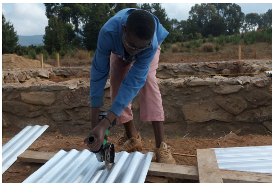
Zuschnitt des Wellblechresten für die Fundamentkrone des Oekonomiegebäudes
