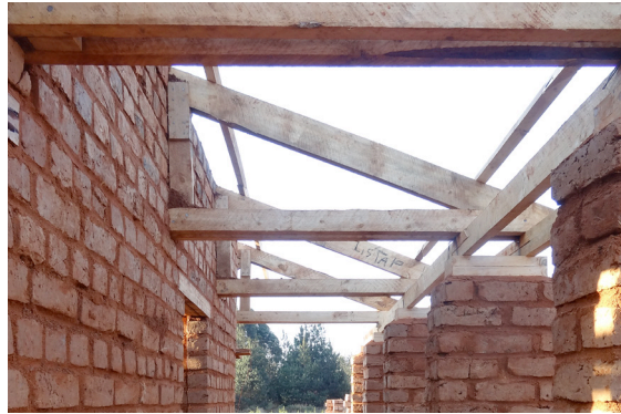
Aufmauerung zwischen Dachbindern
