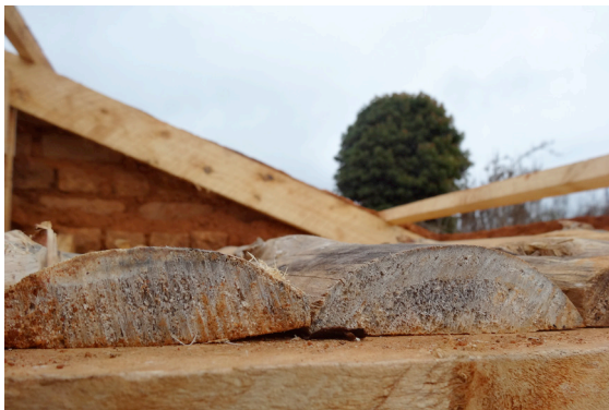
Die Schwarten werden auf die Zange montiert
