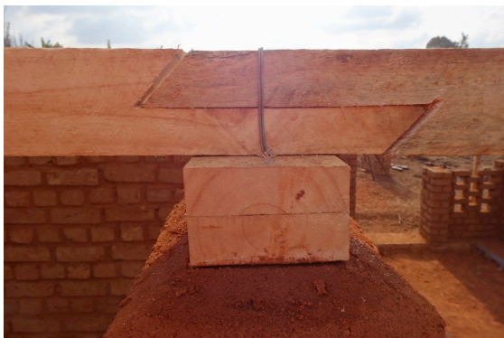
Holzverbindung, Drahtverankerung & Schwelle
