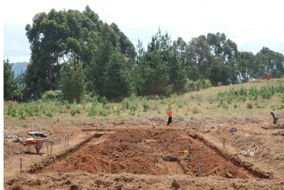
Die Gräben für die Fundamente sind ausgehoben
