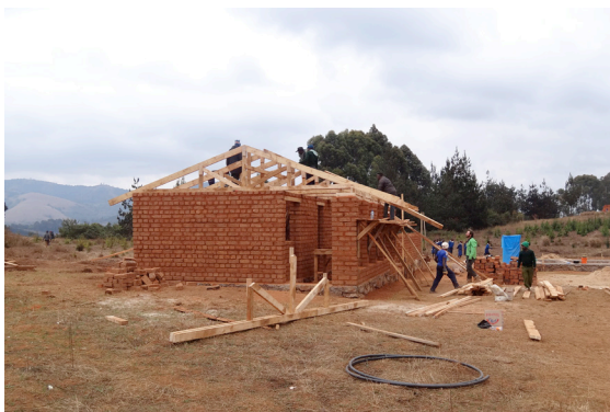
Montage/Ausrichtung Dachbinder und Sparren
