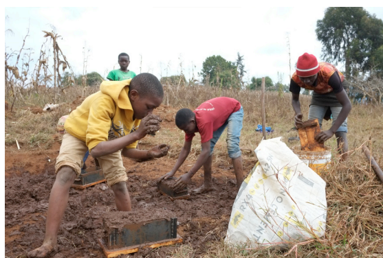
Die fertige Mischung muss in die Schalung gepatzet werden.
