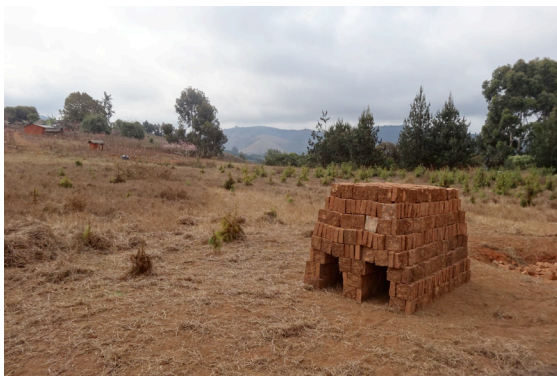
Aufgebauter Ziegelofen
