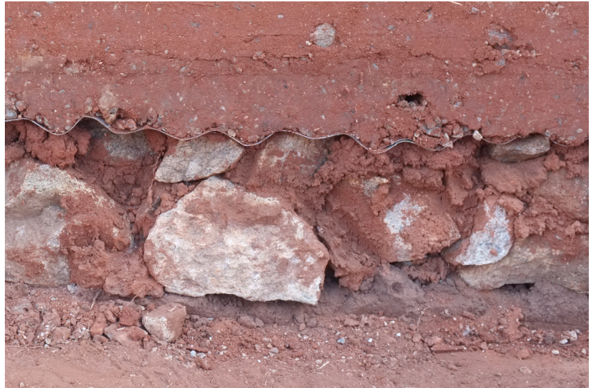
Natursteinfundament für Stampflehmwand, Wellblech schützt vor aufsteigender Feuchtigkeit
