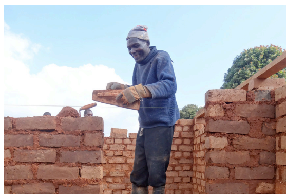
für die Innenwand werden unsere Isele-Adobe verwendet.
