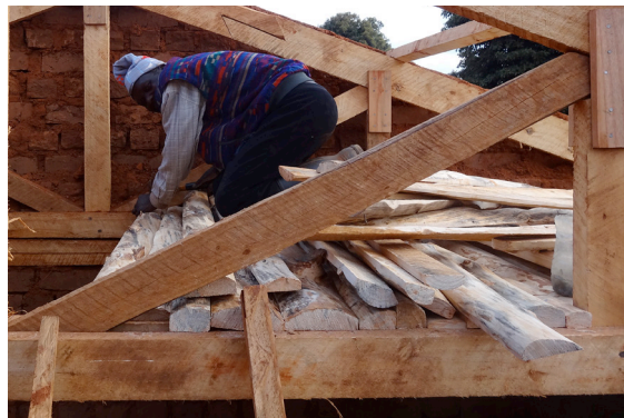
Kassian bei der Montage der Schwartenbretter
