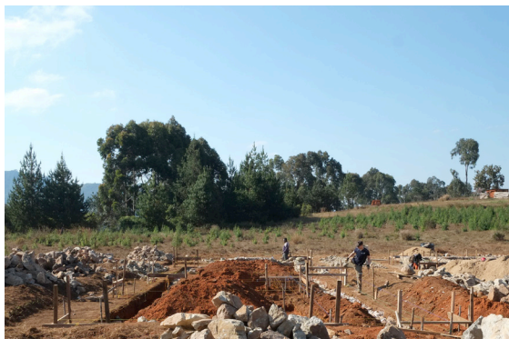
Schnurgerüst und zu ca. 50% gefüllter Fundamentgraben.
